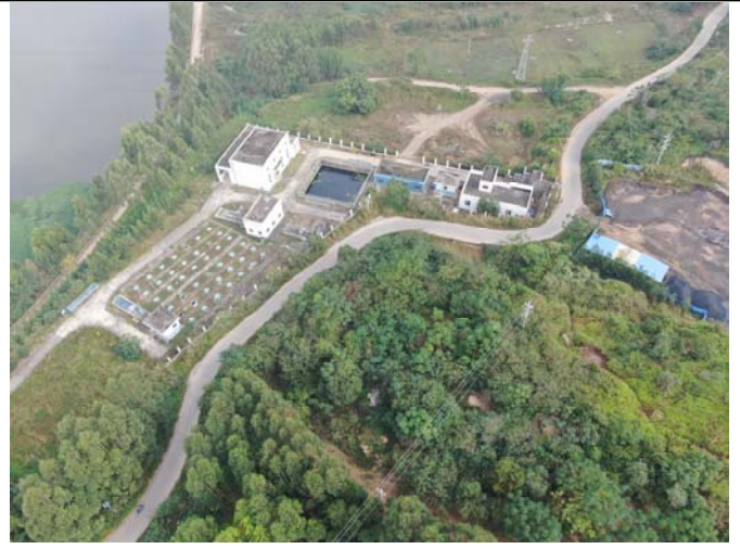
项目小董镇污水厂现状
